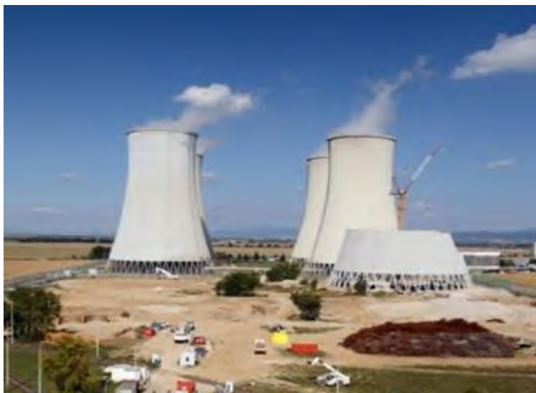
Immagine 3 - Demolizione delle torri di raffreddamento.
