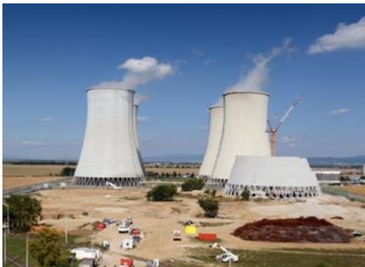
Immagine 3 - Demolizione delle torri di raffreddamento.
