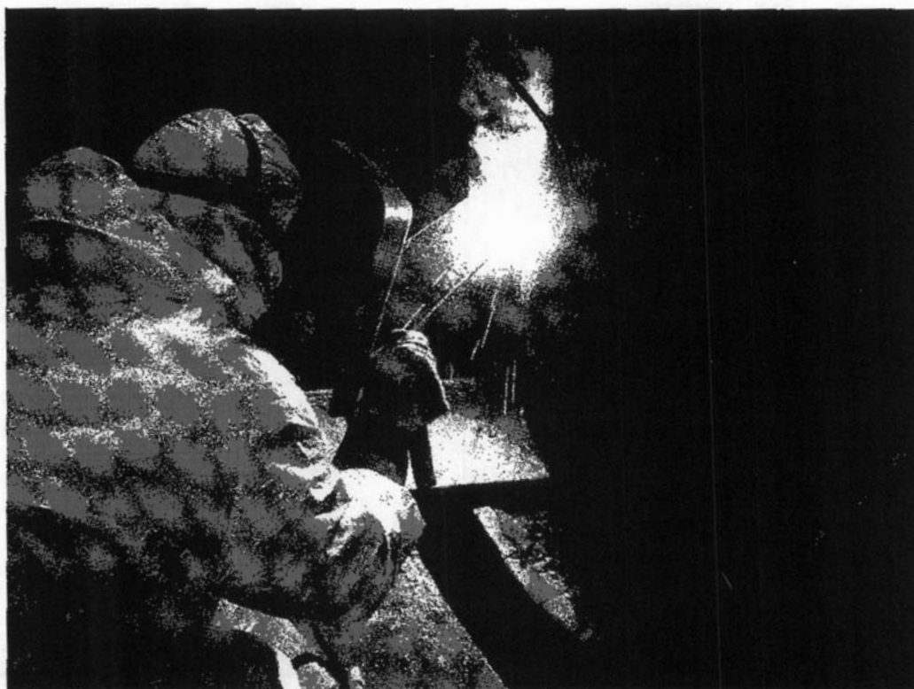
Centrale di Latina - Lavori di bonifica
