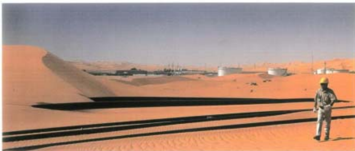
Algeria - Impianto di trattamento di Bir Rebaa
