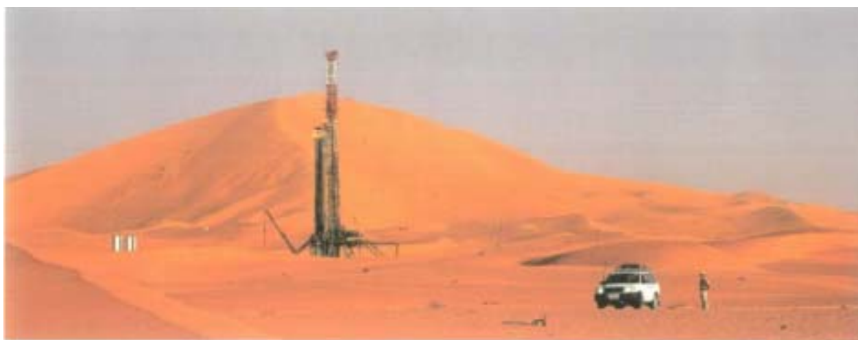
Algeria: Impianto di produzione.
