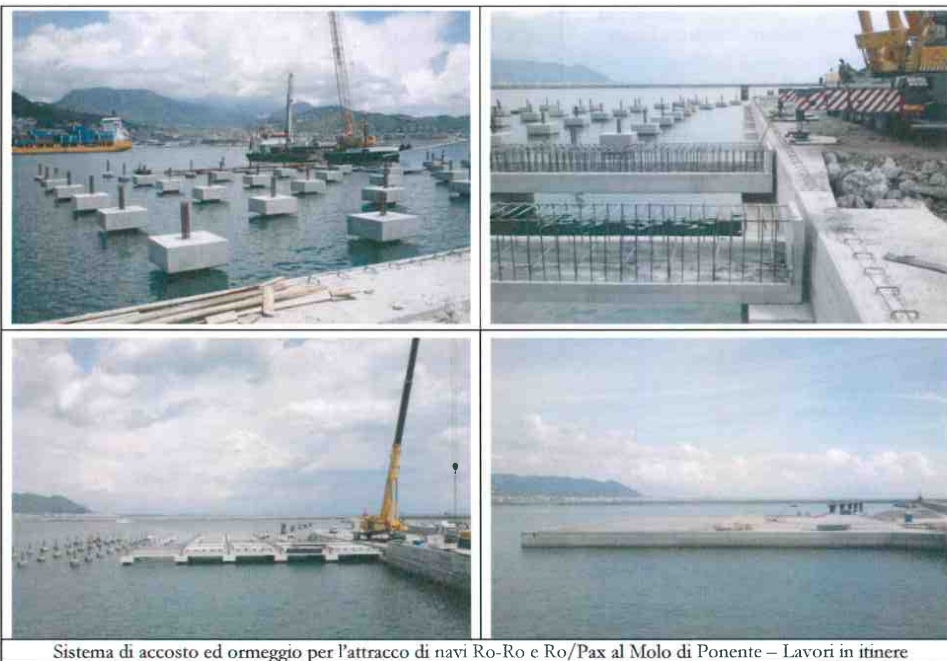
Sistema di accosto ed ormeggio per l'attracco di navi Ro-Ro e Ro/Pax al Molo di Ponente – Lavori in itinere
