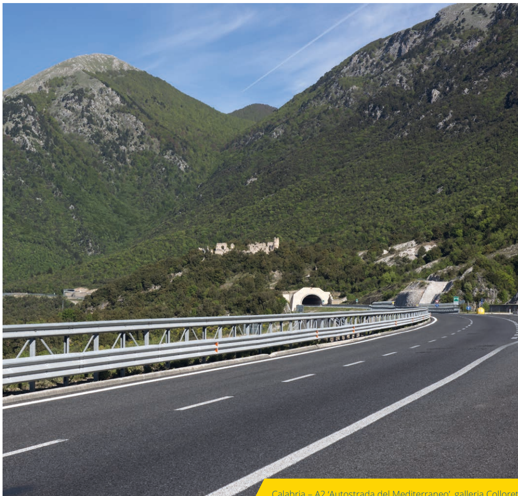
Calabria – A2 'Autostrada del Mediterraneo', galleria Colloredo
