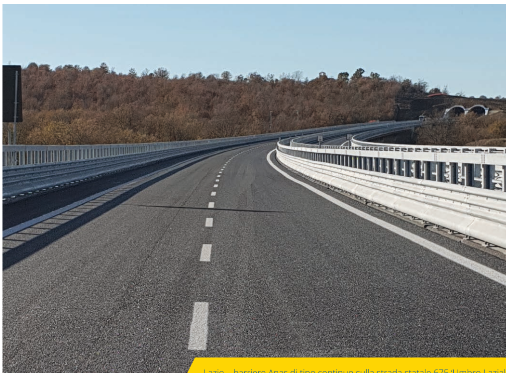
Lazio – barriere Anas di tipo continuo sulla strada statale 675 'Umbro Laziale'
