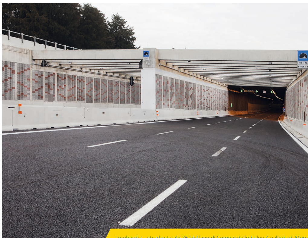
Lombardia - strada statale 36 'del lago di Como e dello Spluga', galleria di Monza
