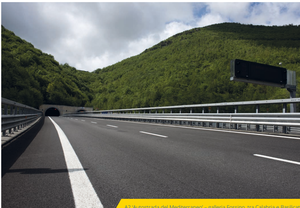
A2 'Autostrada del Mediterraneo' - galleria Fossino, tra Calabria e Basilicata
