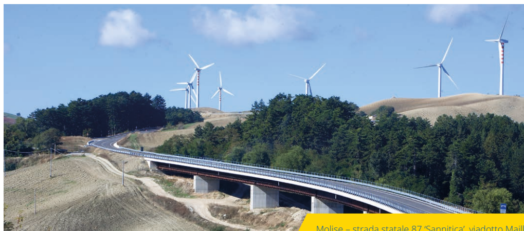
Molise – strada statale 87 'Sannitica', viadotto Maillo
