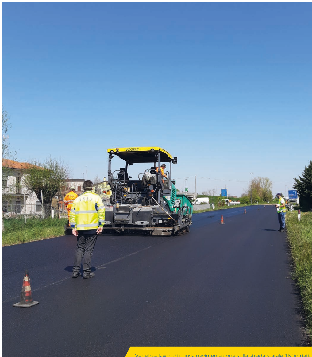
Veneto – lavori di nuova pavimentazione sulla strada statale 16 'Adriatica'
