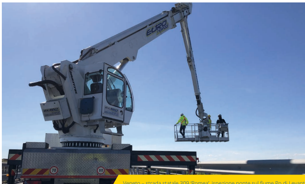
Veneto – strada statale 309 'Romea', ispezione ponte sul fiume Po di Levante
