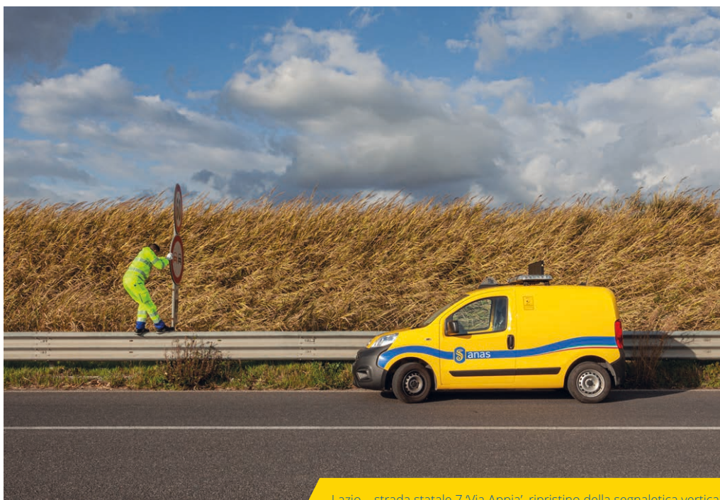
Lazio – strada statale 7 'Via Appia', ripristino della segnaletica verticale
