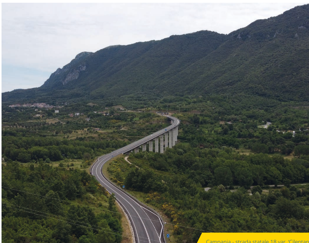
Campania - strada statale 18 var. 'Cilentana'
