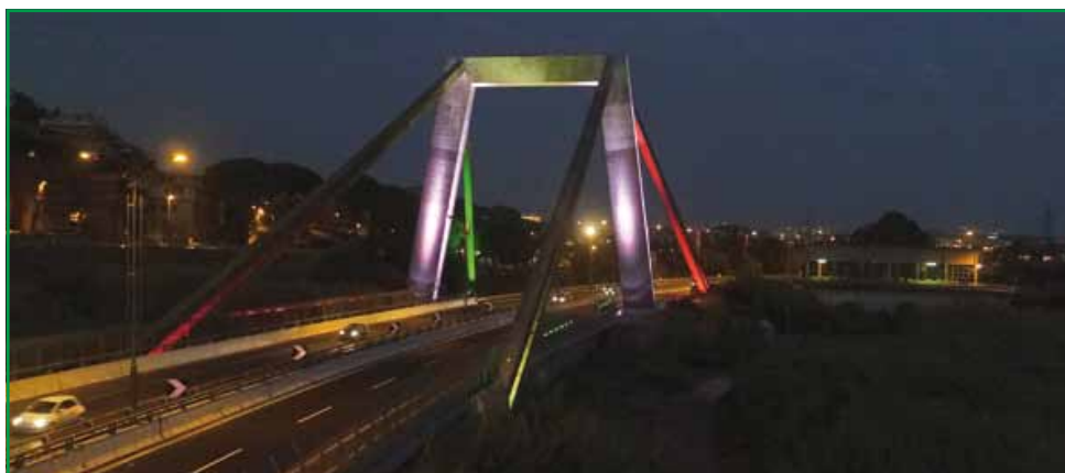
A91 Autostrada Roma-Aeroporto di Fiumicino - Ponte "Morandi"
