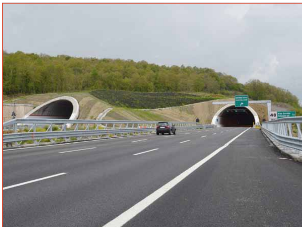
A2 "Autostrada del Mediterraneo" - Galleria "Sant'Angelo"
