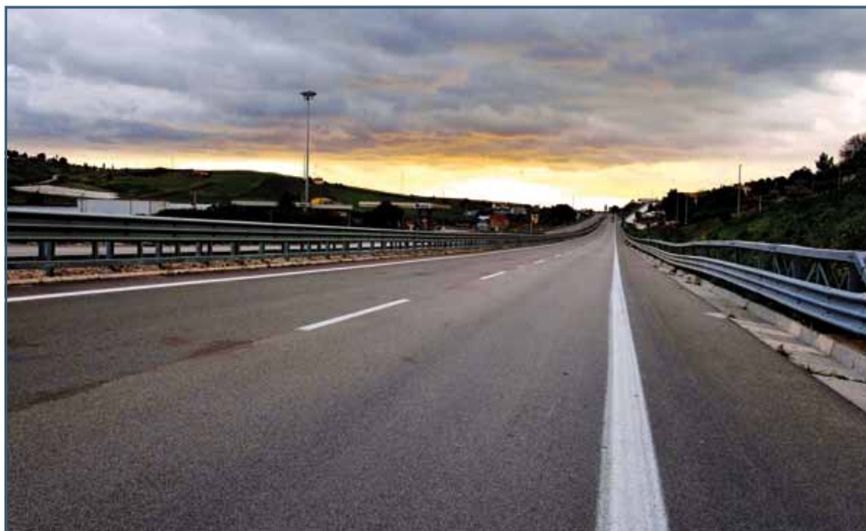
S.S.640 "Strada degli Scrittori" - Viadotto "San Benedetto"
