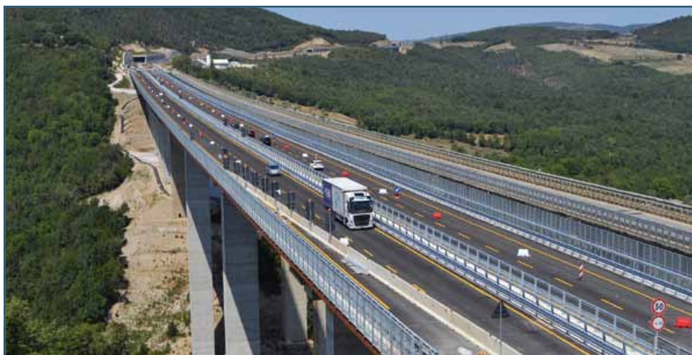
E78 "Grosseto-Fano" - Viadotto "Farma"
