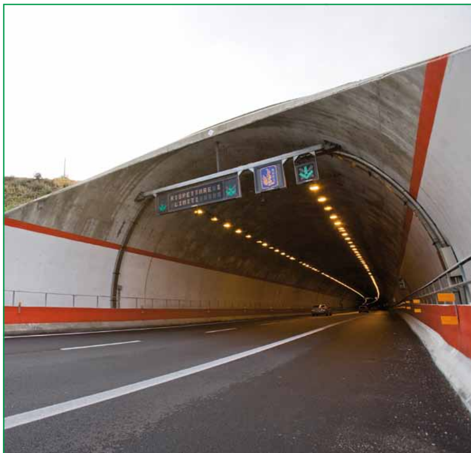
Autostrada Catania-Siracusa - Galleria "San Demetrio"
