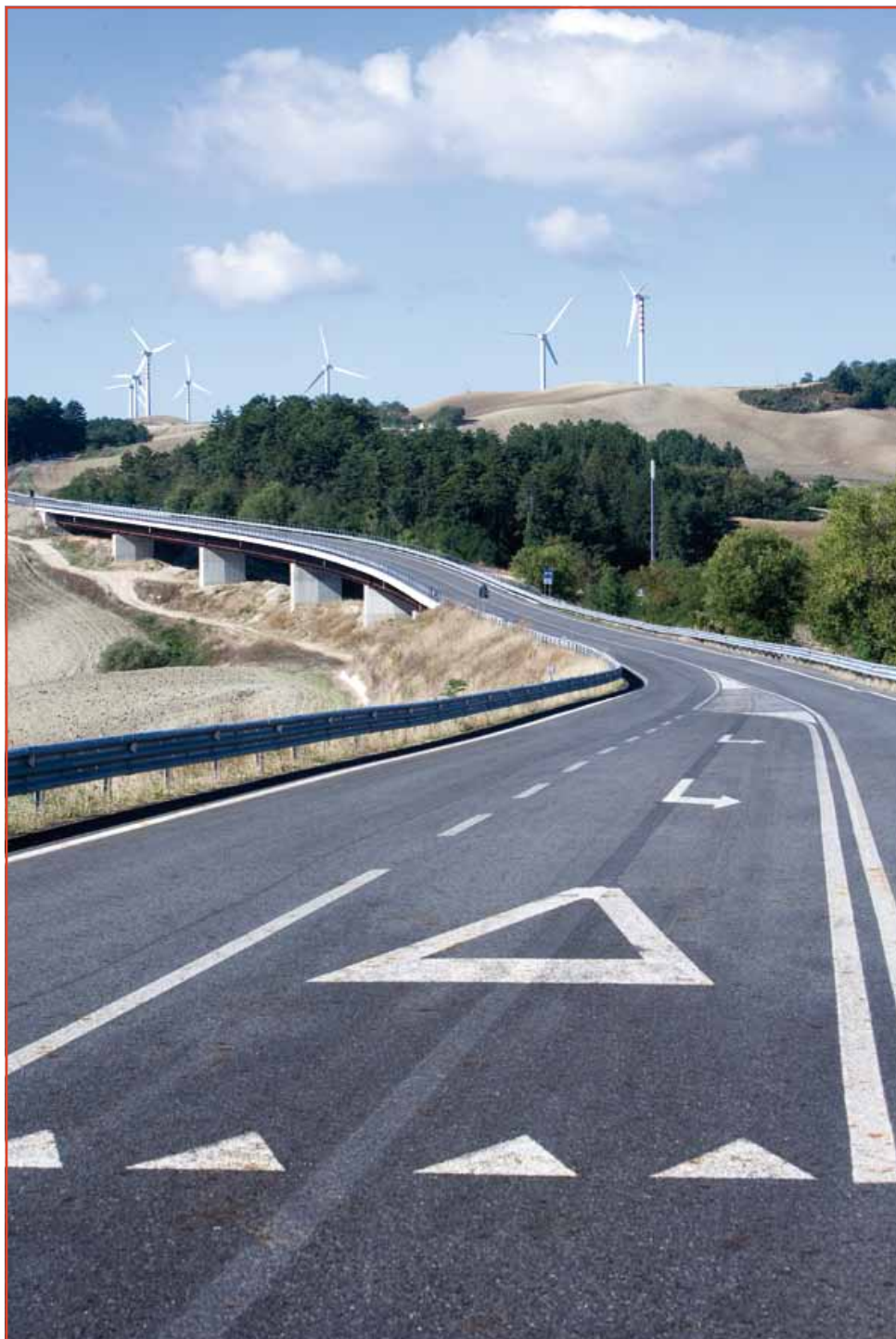
S.S.87 "Sannitica" - Viadotto "Maillo"
