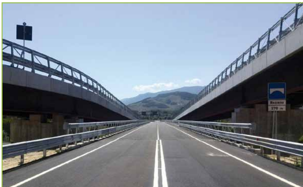
S.S.684 dir. "Tangenziale Sud L'Aquila" - Viadotto "Bazzano"
