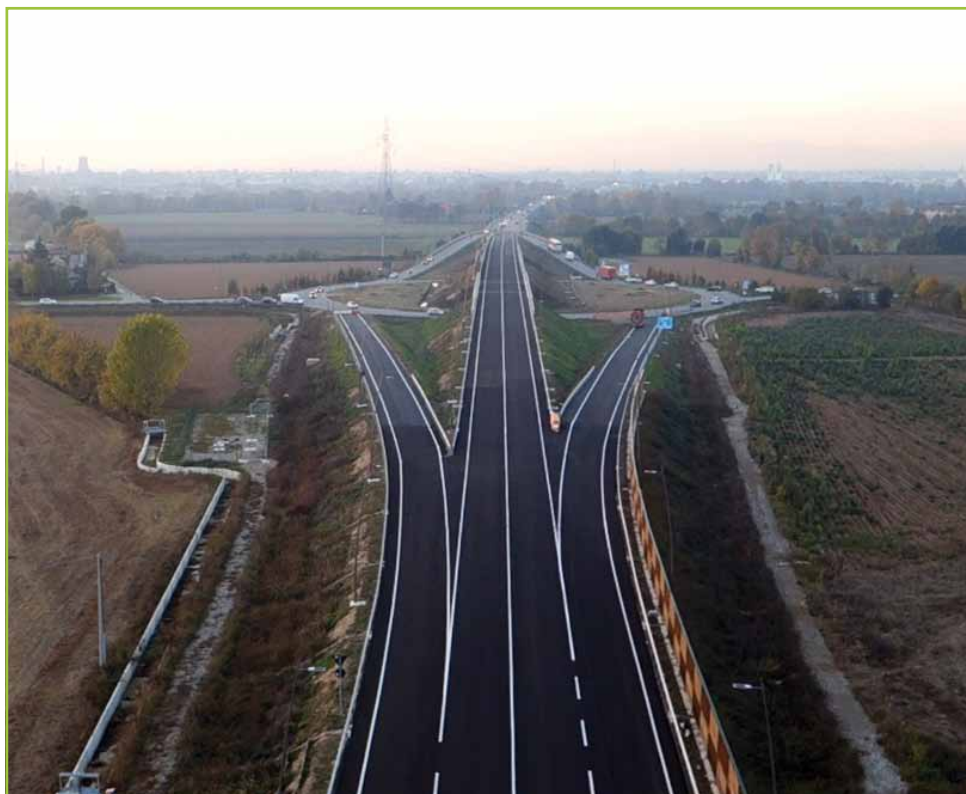
S.S.42 "Del Tonale e della Mendola" - Tangenziale Sud Bergamo
