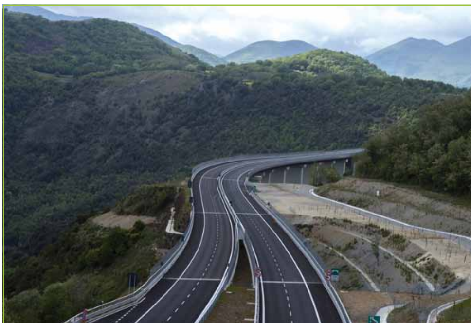
A2 "Autostrada del Mediterraneo" - Viadotto "Italia"
