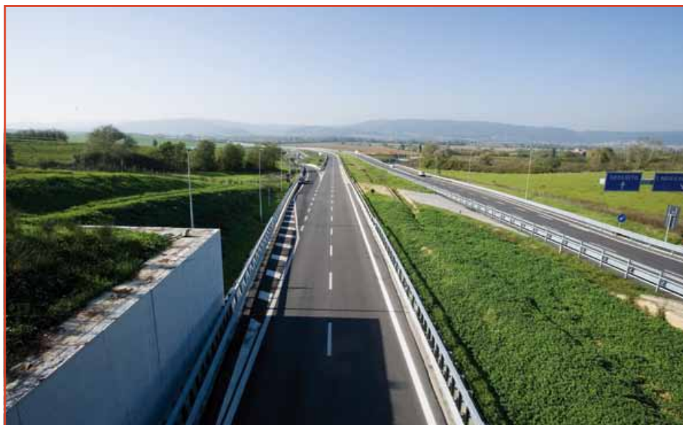
E78 "Grosseto-Fano" - Svincolo di San Rocco a Pieve
