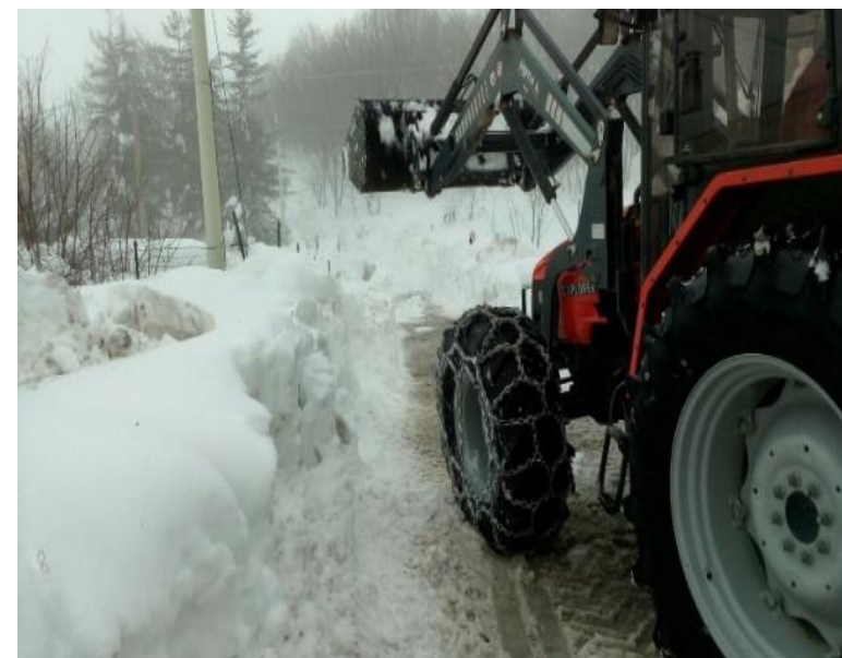
Strada accesso linea Montebello Pescara 21/01/2017
